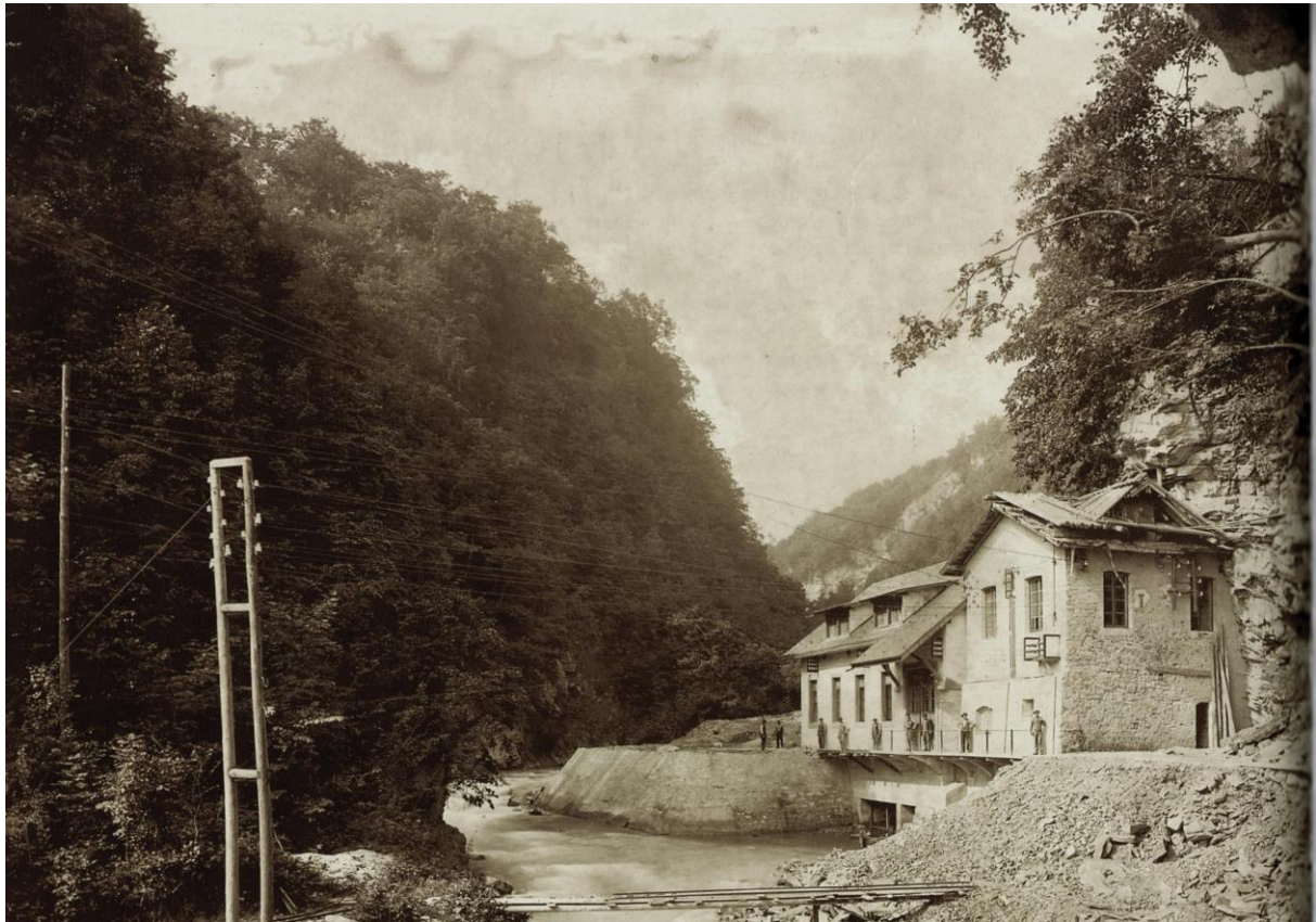
Usine électrique de la Vièze reconstruite après les inondations du 16 novembre 1895 qui avaient emportés les barrages construits par la fabrique de sucre Hevetia.
